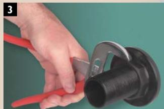
3. Apriete la tuerca para que las caras de las dos arandelas hagan contacto con la pared del estanque para obtener un sellado hermético. Cerciórese de que se cumple con las especificaciones de los fabricantes de estanques. No apriete demasiado.
