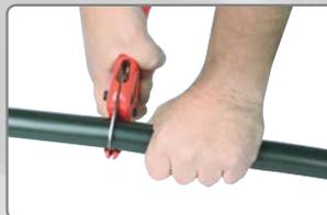
1. Corte la tubería con un cortador de tubos, cuchillo o sierra-serrucho. Asegúrese que el corte final es plano, en ángulo recto. Mantenga el tubo limpio y libre de partículas o rayones-imperfecciones como sea posible.
