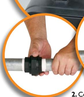
2. Conecte la nueva tubería enroscando la tuerca común central sobre la conexión macho roscada.
