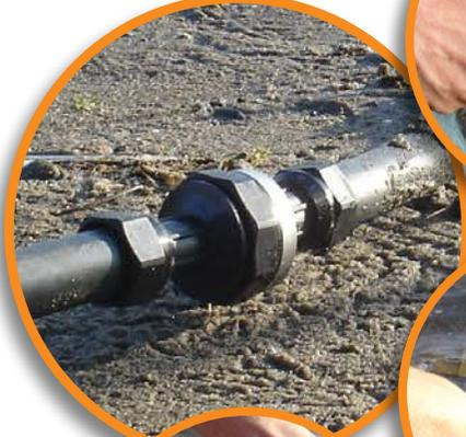
1. Alinee los dos puntos finales de la unión acople rápido articulado.
